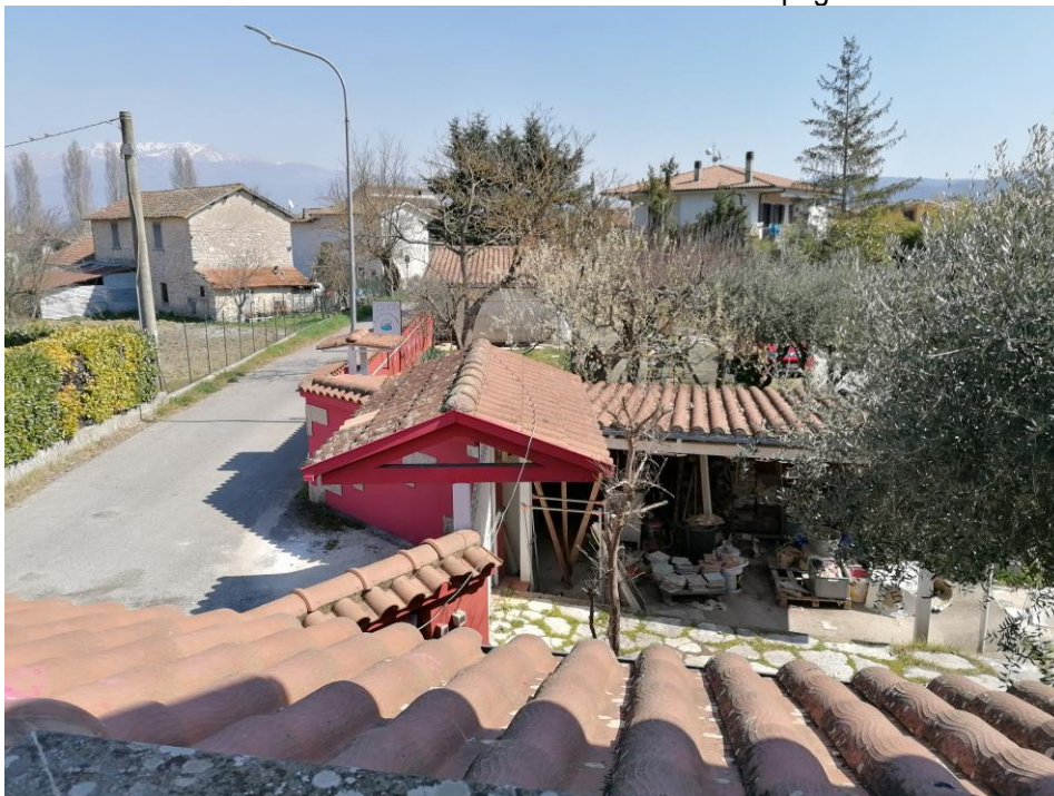
FOTO N°51: Tettoia esterna al Piano di Campagna.
