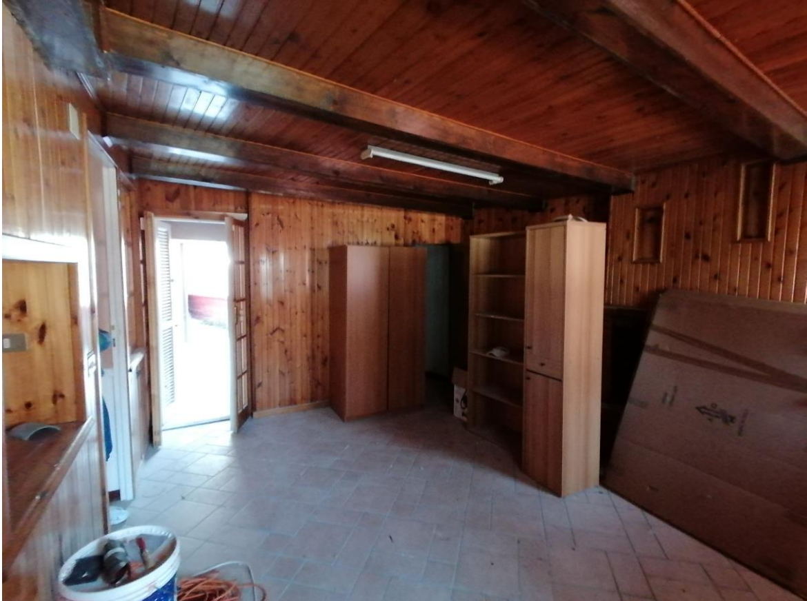
FOTO N°33: Corpo C – Sala – PT (2/2).
